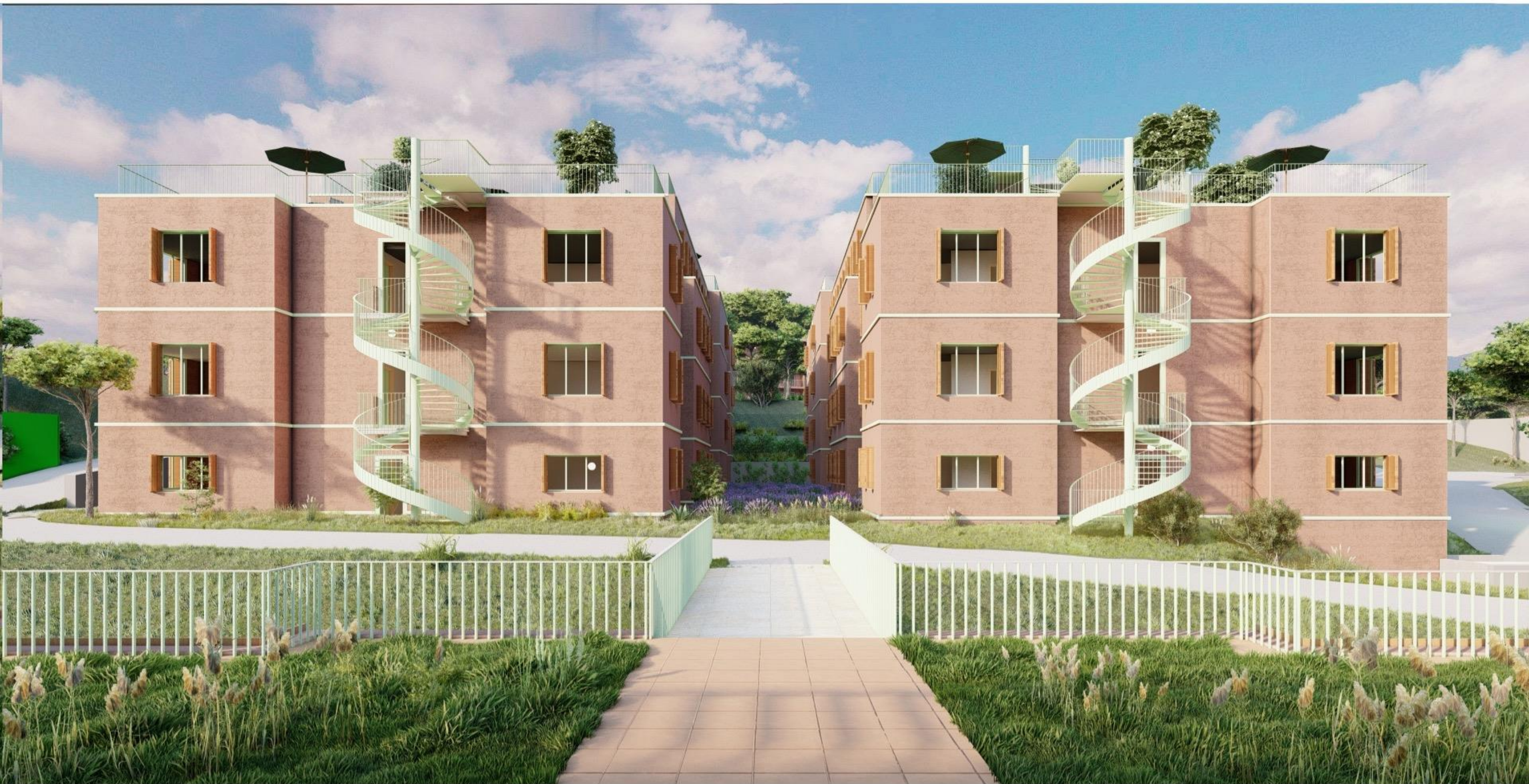
UNE MISE EN VALEUR DE L'ARCHITECTURE EXISTANTE
